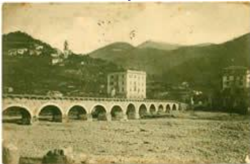
Genova, Ponte Carrega
